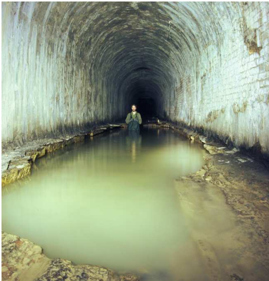
Рис. 4. Промоина в днище коллектора Клова (Киев) глубиной 1 м, образовавшаяся в ливни 2014 года. Фото Коробко Н.В.
