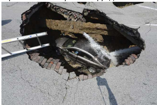
Рис. 3. Антропогенно спровоцированный суффозионный размыв грунта, приведший к провалу в Толедо. С сайта:
