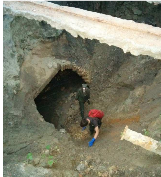
Рис. 5. Провал глубиной около 10 м на месте разрушения коллектора р.Сырец в Киеве в 2014 году. Фото Коробко Н.В.
